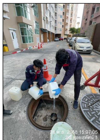
รูปภาพที่ 2.31 การเติมเชื้อจุลินทรีย์ระบบบำบัดน้ำเสีย
