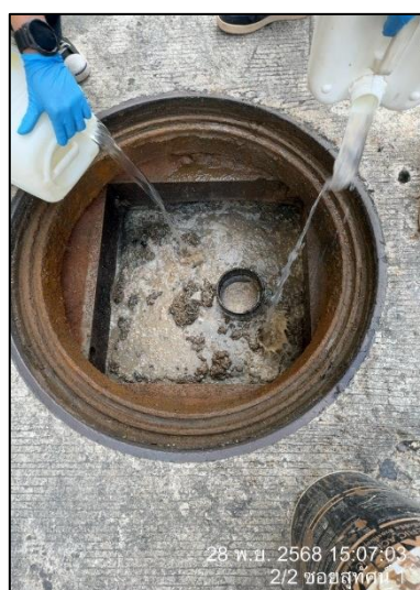
รูปภาพที่ 2.31 การเติมเชื้อจุลินทรีย์ระบบบำบัดน้ำเสีย
