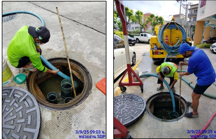
รูปภาพที่ 2.9 การสูบน้ำ
